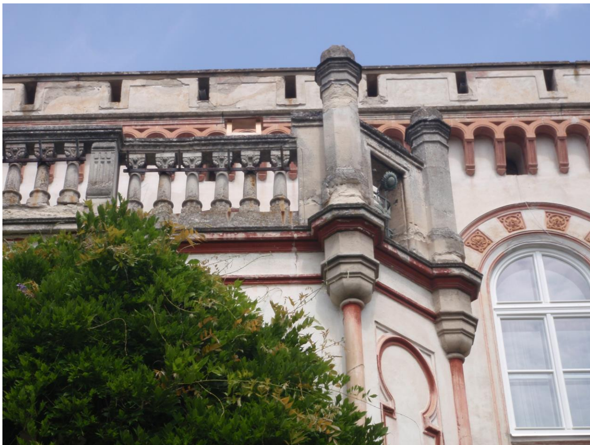
Ukázka oslabených pat pískovcových pilířků u zábradlí terasy.
