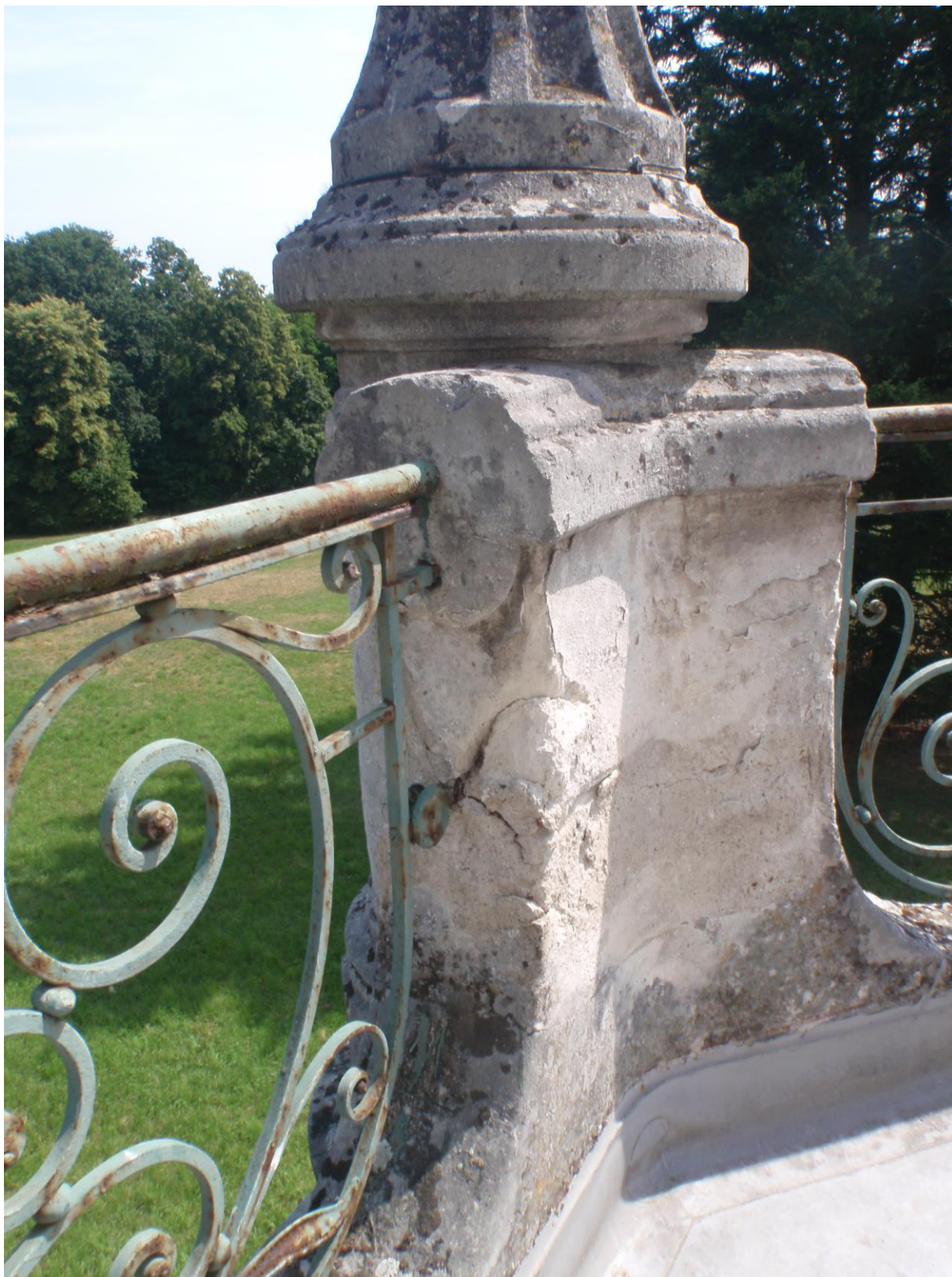
Pilířky zábradlí teras (z pískovce) jsou místně narušeny prasklinami.....
