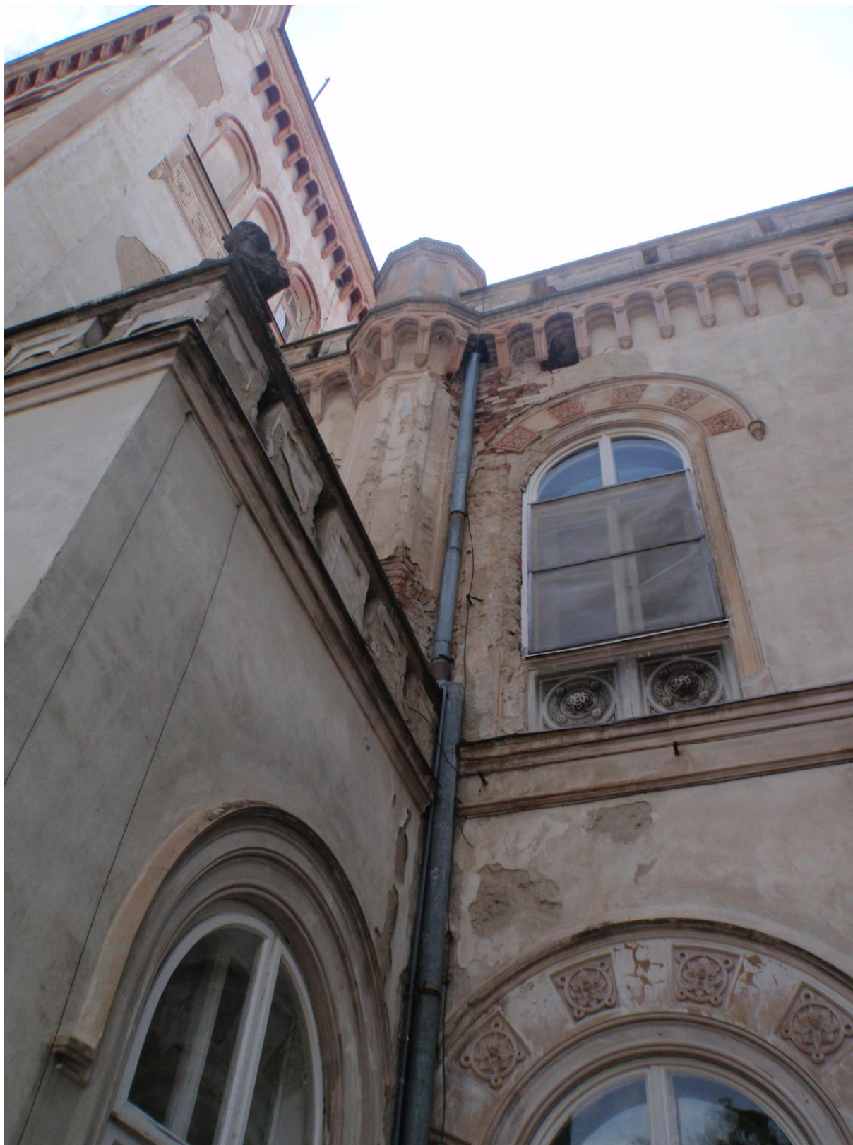
Ukázka poruchy – degradace pojiva zdiva v místech zatékání.
